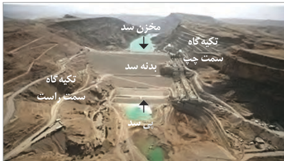
شکل ۴-۵- نمایی از بخش‌های مختلف یک سد
