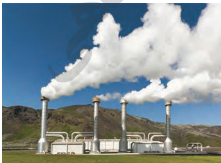
شکل ۱۱-۶- نیروگاه زمین گرمایی مشکین شهر- اردبیل
