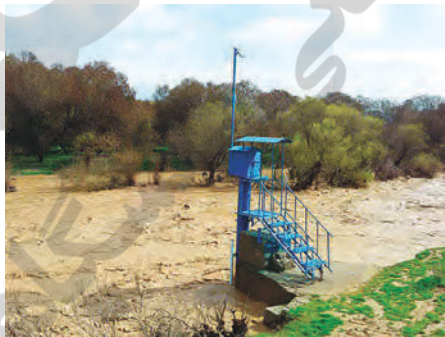
شکل ۲-۳. ایستگاه اندازه‌گیری آبدهی رود
