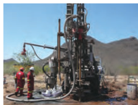
ب) دستگاه حفاری گمانه
