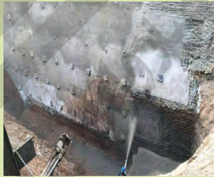
پایدارسازی شیب به روش میخ کوبی
