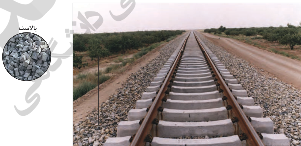
شکل ۴-۱۱- بالاست در زیرسازی جاده ریلی
