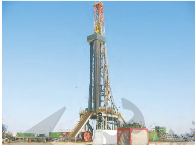
شکل ۱۰- دکل حفاری چاه‌های اکتشافی نفت و گاز
