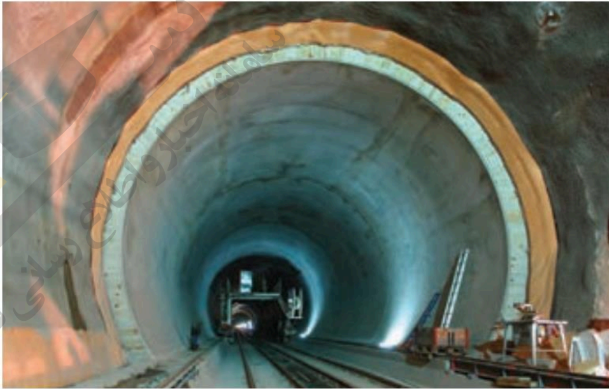
شکل ۴-۶- پوشش داخلی تونل به وسیله قطعات بتن
