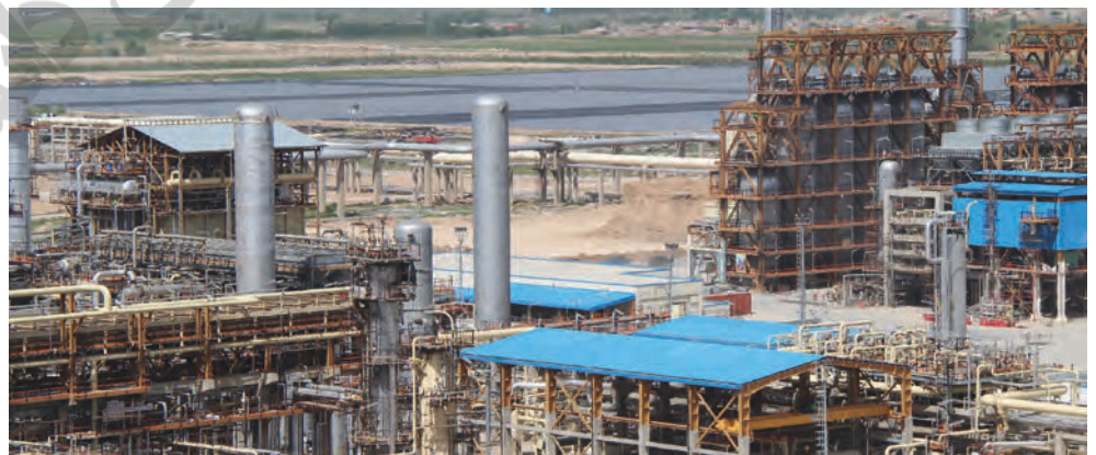
شکل ۴- نمایی از یک برج تقطیر برای جداسازی اجزای هوا در پتروشیمی ماهشهر
