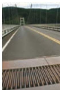
(ب) نمونه‌ای از بست‌های انبساطی
